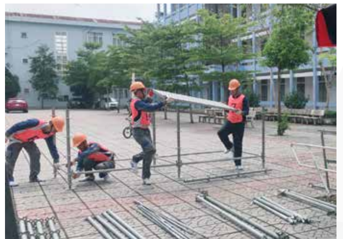
足場組み立て試験
